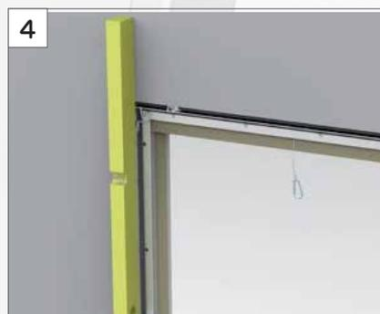
Potom čvrsto fiksirajte ram za otvor uz pomoć integrisanih elemenata i ponovo proverite pravougaonost okvira.
